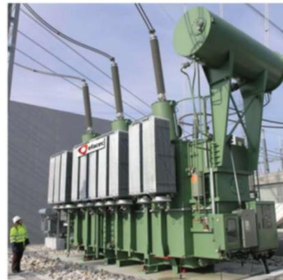
Figura 1. Transformador de Potência da RNT
