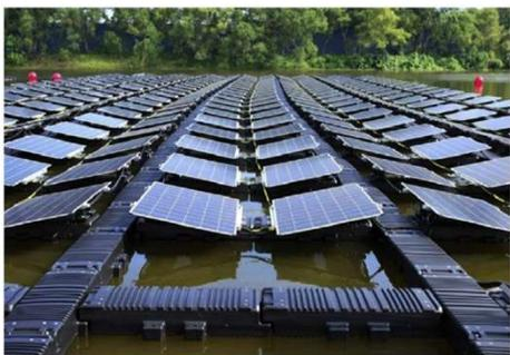
Figura 3. Estrutura Flutuante (Tipo 2)
